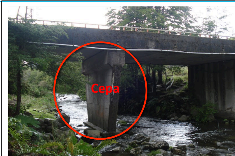
Puente Río Blanco
